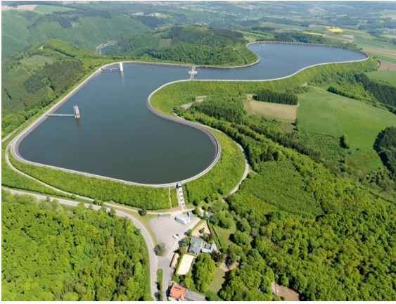
Figure 9 Oberes Becken der SEO
