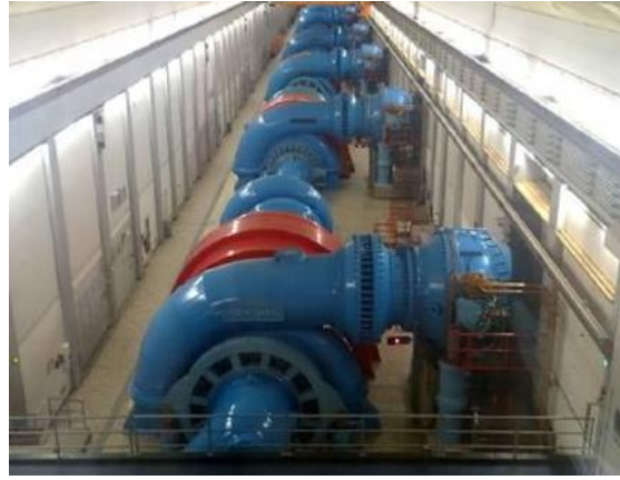
Figure 10 Turbinehallen der SEO
